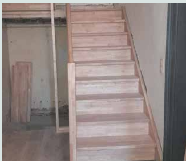
Remplacement des escaliers dans les logements sociaux
