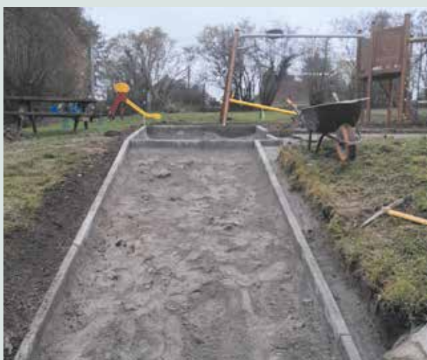
Création d'une rampe PMR à la plaine de jeux de Scry
